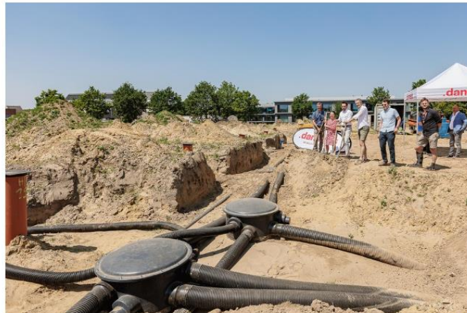
De leidingen liggen al klaar om de verschillende woningen ondergronds te verbinden met de centrale bron van het nieuwe BEO-veld. — © Dirk Vertommen
