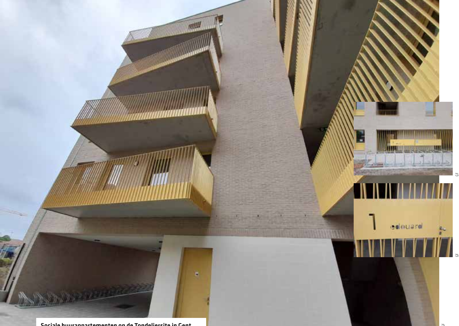
Sociale huurappartementen op de Tondeliërsite in Gent. Tondelië werd ontwikkeld in regie van de stad.
